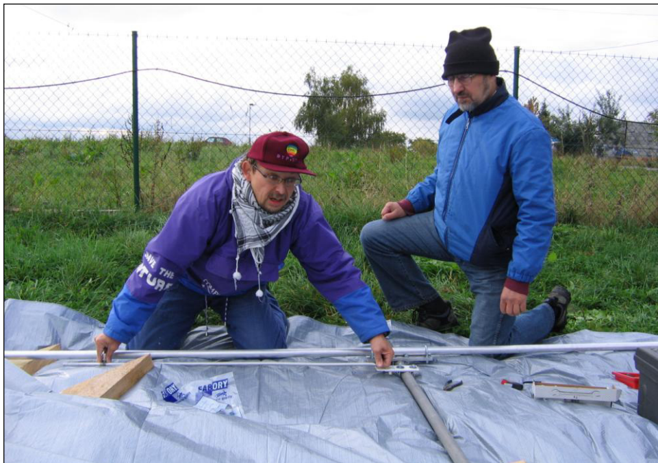
Tom OK1DXD montuje anténu HB9CV pro 18 MHz, nahoře mu asistuje Pavel, OK1MN ... ... zatímco dole vidíme zářný příklad týmové spolupráce
