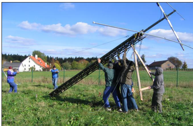
Tom OK1DXD montuje anténu HB9CV pro 18 MHz, nahoře mu asistuje Pavel, OK1MN ... ... zatímco dole vidíme zářný příklad týmové spolupráce
